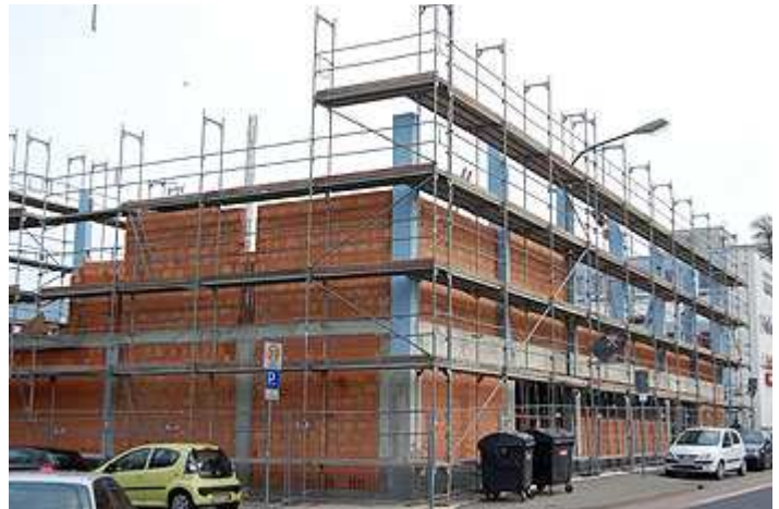
Hier entsteht die neue Sporthalle.
